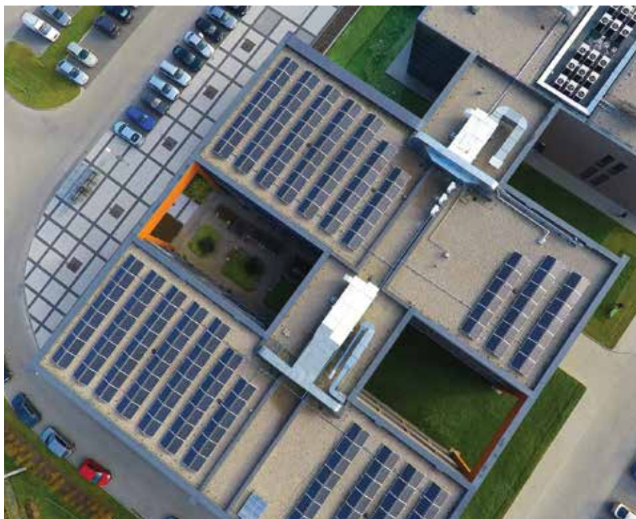
Słupski Inkubator Technologiczny – instalacje OZE (fot. SSSE)
