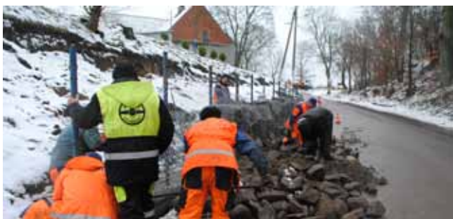
W Wiklinie powstaje chodnik na zboczu skarpy, który znacznie poprawi bezpieczeństwo pieszych. Deptak będzie biegł 2 m nad przebiegającą obok drogą.
