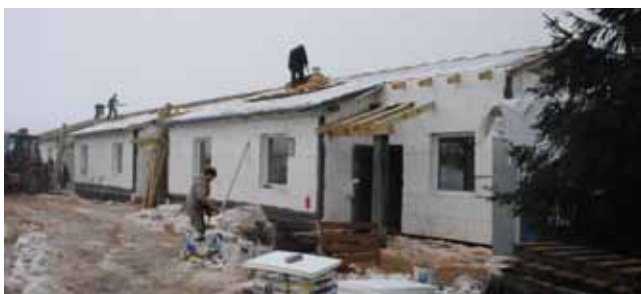
W Wieszynie powstaje budynek socjalny. Znajdą się w nim 4 mieszkania dwupokojowe i 2 trzypokojowe. Budynek będzie gotowy do użytku z końcem czerwca br.
