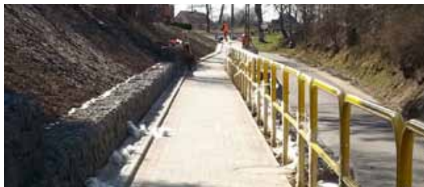
W Wiklinie dobiega końca budowa 200 m chodnika z polbruku na skarpie. Skarpy chodnika zabezpieczone będą gabionami i płytami ażurowymi MEBA.
