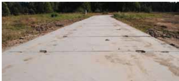
Bydlino. Na ul. Lazurowej i Koralowej wybudowano drogę z betonowych płyt drogowych typu POZBET. Inwestycja została przeprowadzona na nowopowstającym osiedlu naprzeciwko osiedla Złoty Potok.
