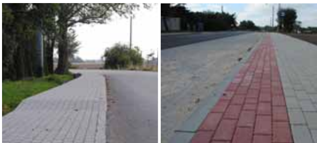
Krzemienica i Bruskowo Małe. W obu miejscowościach została położona nowa nawierzchnia na drodze. Powstały również nowe fragmenty chodników. Inwestycja była współfinansowana ze Starostwem Powiatowym.
