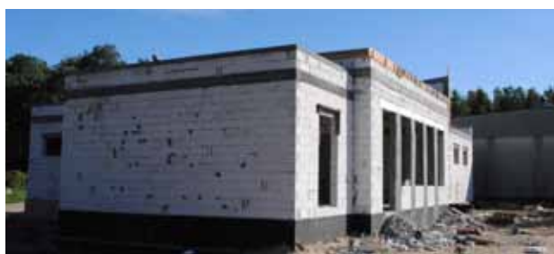
Wrzeście. Trwa budowa świetlicy wiejskiej. Budynek będzie połączony z budynkiem szkoły. Oprócz sali świetlicy powstanie tutaj także gabinet stomatologiczny. To największa inwestycja tego roku.
