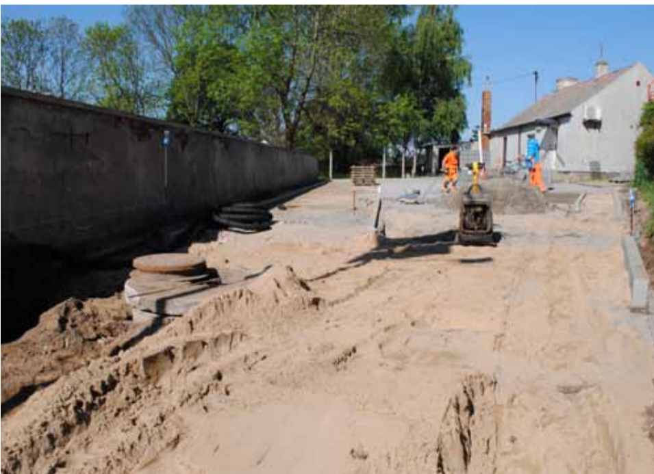
Na drodze dojazdowej do sklepu w Strzelinie już nie będzie się kurzyć.
