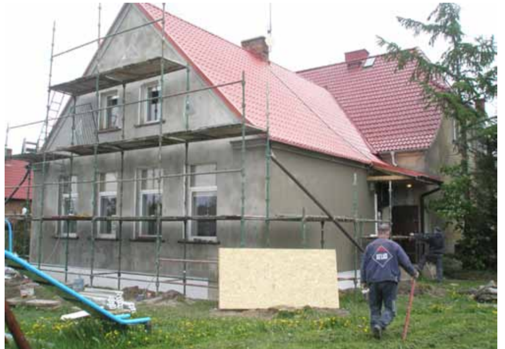
Docieplana jest świetlica w Krzemienicy, trwa również budowa chodnika i powstaną miejsca postojowe.
