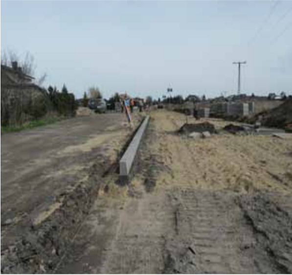
Trwa budowa drogi na ulicy Rzemieślniczej w Siemianicach. Powstają też drogi w Niewierowie, Bydlinie i Stanięcinie.
