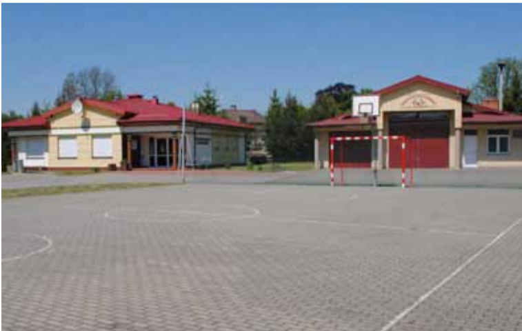
Wymarzony kompleks każdej miejscowości: remiza, świetlica, boisko i plac zabaw w jednym miejscu.
