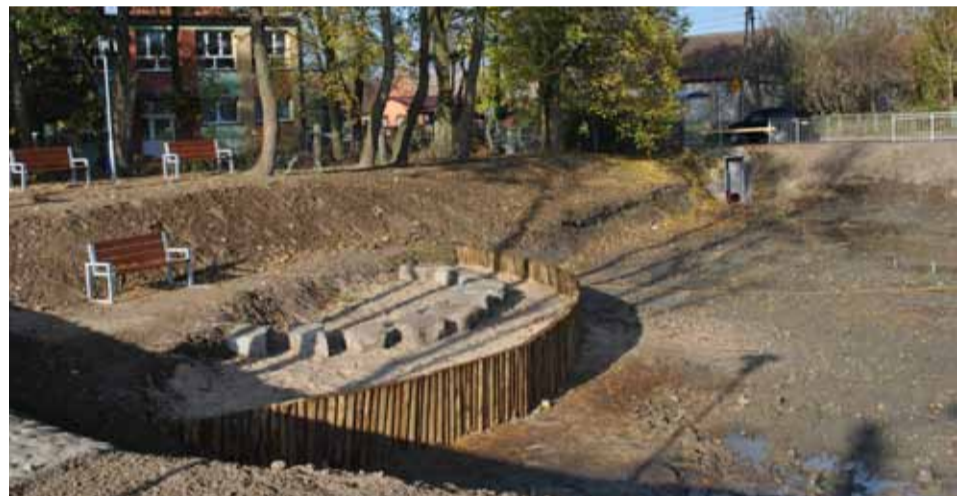
Trwają prace przy zagospodarowaniu stawu ppoż. w Bierkowie. Obok powstanie również plac zabaw
