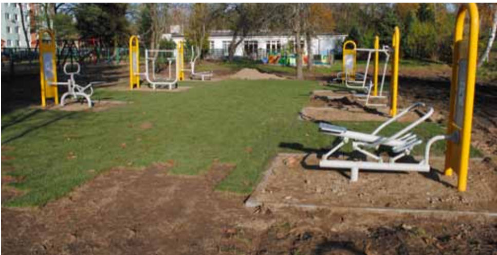
W Redzikowie Osiedlu trwa odnawianie placu zabaw. Montowane są również urządzenia siłowni zewnętrznej.
