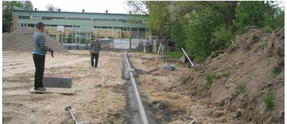
Bierkowo - budowa boiska
