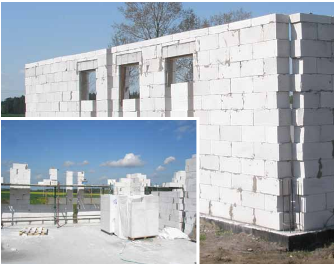
Budowa świetlicy w Kukowie
