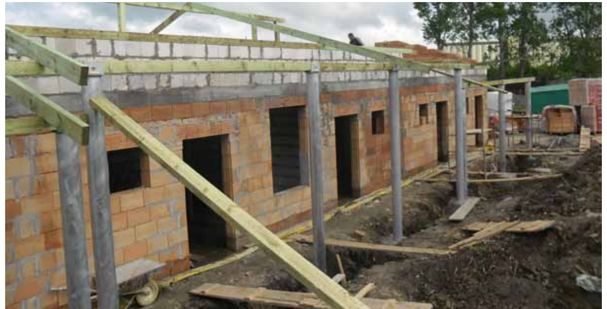
Jezierzyce - budowa nowego osiedla
