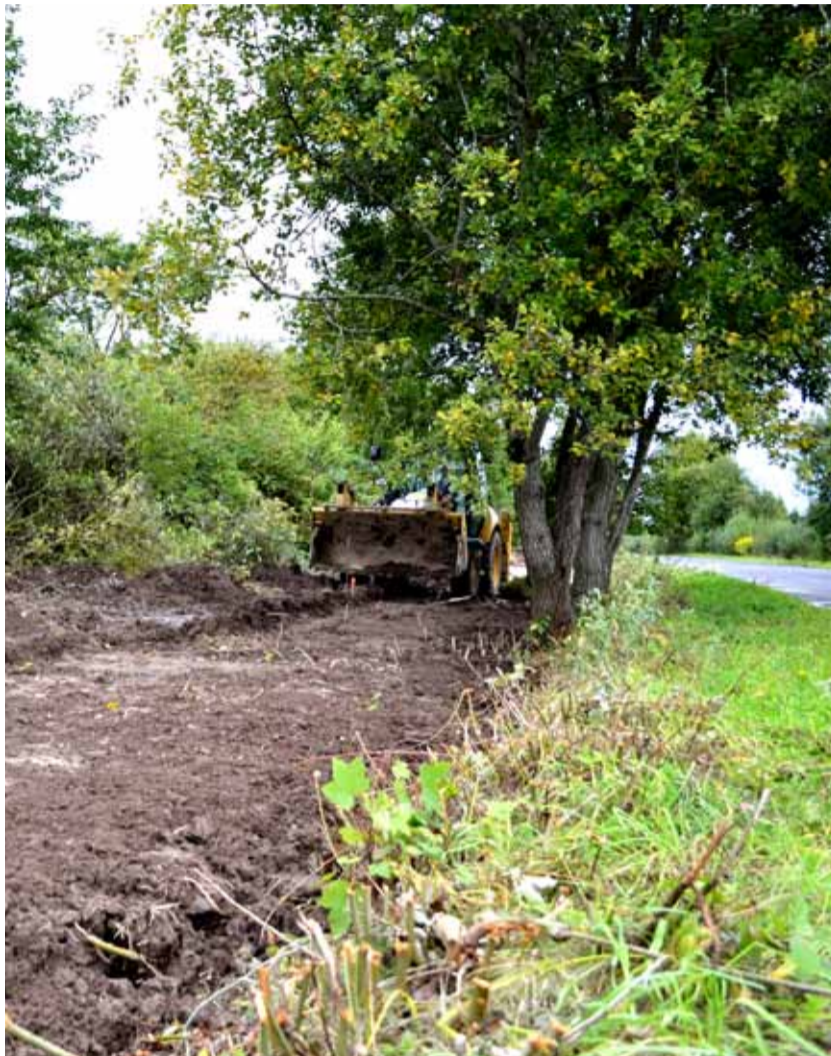
Rozpoczęły się prace na ścieżce rowerowej do Bierkowa PGO. Ścieżka będzie łączyć się z istniejącą już przy drodze powiatowej ze Słupska.
