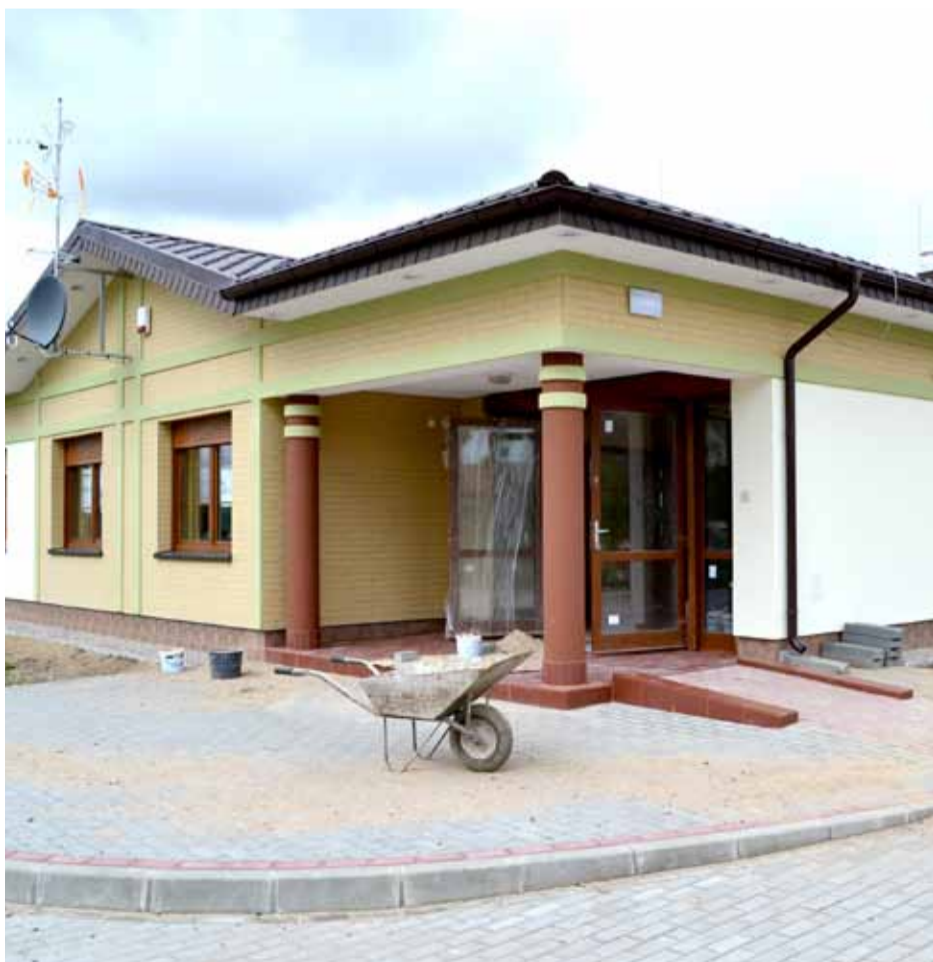
Świetlica w Kukowie z zewnątrz wygląda na wykończoną. Trwają jeszcze prace w pomieszczeniach, efekt będzie można podziwiać w przyszłym miesiącu.
