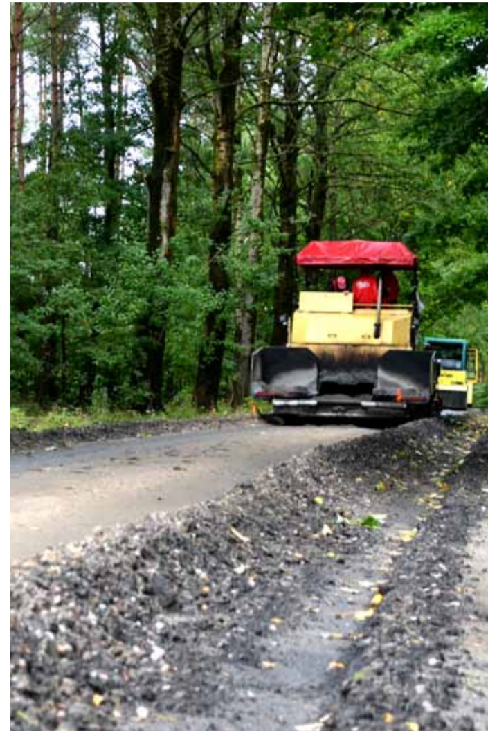
Wrzeście – Kępno, już w październiku między tymi miejscowościami będzie można przemieszczać się nową drogą betonową.
