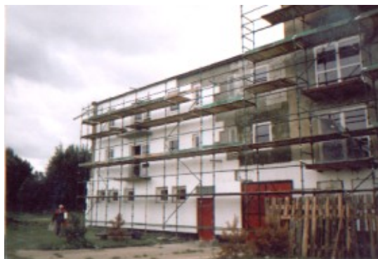
Obskurna elewacja została docieplona
